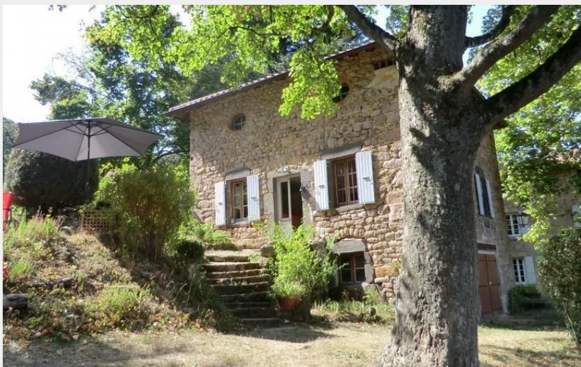
Crédit photo : Vue du gîte en arrivant (Gîtes de France)
