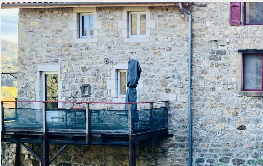
Crédit photo : Extérieur (N Malassis)
