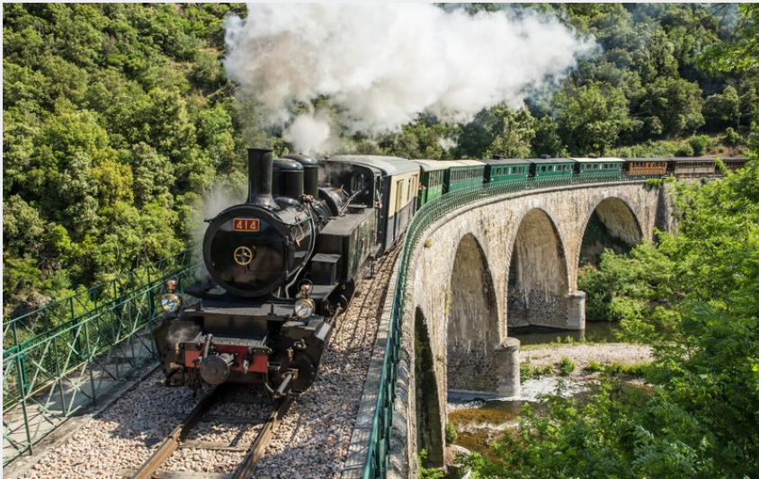
Crédit photo : Train Ardèche (S. Bridot)
